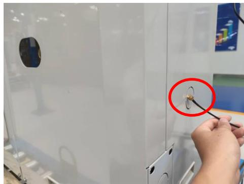
网关天线可从侧盖板的孔处穿出，若无预留孔，可现场钻眼拉出天线
